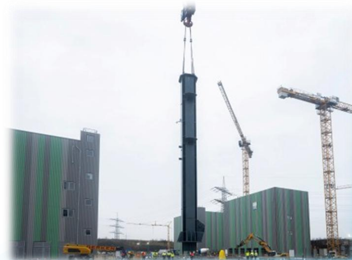
Montage 1. Stütze des DR-Turms Februar 2026
